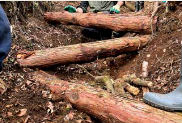
③配置／下流側に丸太を斜めに据え、力のかかる方の土手の土砂を削り、ひっかけるように据え、カケヤで固定します。次に上流側に二本目の丸太を一本目の力がかかるところにひっかけるように配置し、これを繰り返します。据える高さは植生が戻ることを想定しつつ、各丸太は下流側にわずかに勾配をつけ、丸太のふちを蛇行しながら雨水がゆっくり流れるようにします。丸太と丸太の段差(踏み上げの高さ)は、歩きやすい15～20cmとします。これ以上の高さでは、人は無意識に歩きやすいところを求め、路肩部の植生を踏みつける恐れがあるということです。
