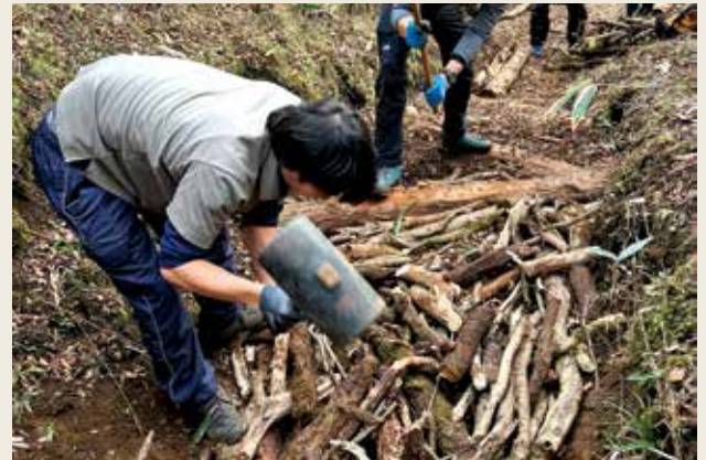
⑤中詰め叩き／隙間を埋める枯れ枝などは、体積を稼ぐ大きいものから隙間を詰める小さいものまで、バランスよく詰めていき、最後に土と落ち葉を敷き、踏み面を仕上げます。
