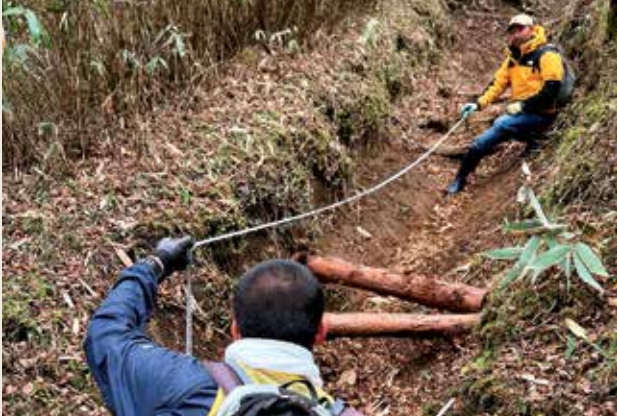
①補修する区間の距離や高さ、幅などを計測します。
