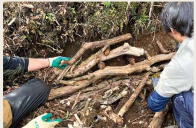
⑥法面(のりめん)保護／土が露出した法面は、冬になると霜柱が出来て表土を浮かせてしまうのを防ぐため、枯木や落ち葉で覆い、植生が戻りやすくします。
