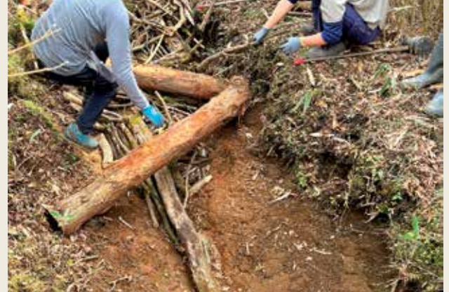
④中詰め／骨格となる丸太を据えたら、隙間に端材や枯木などを踏み面まで詰めていきます。
