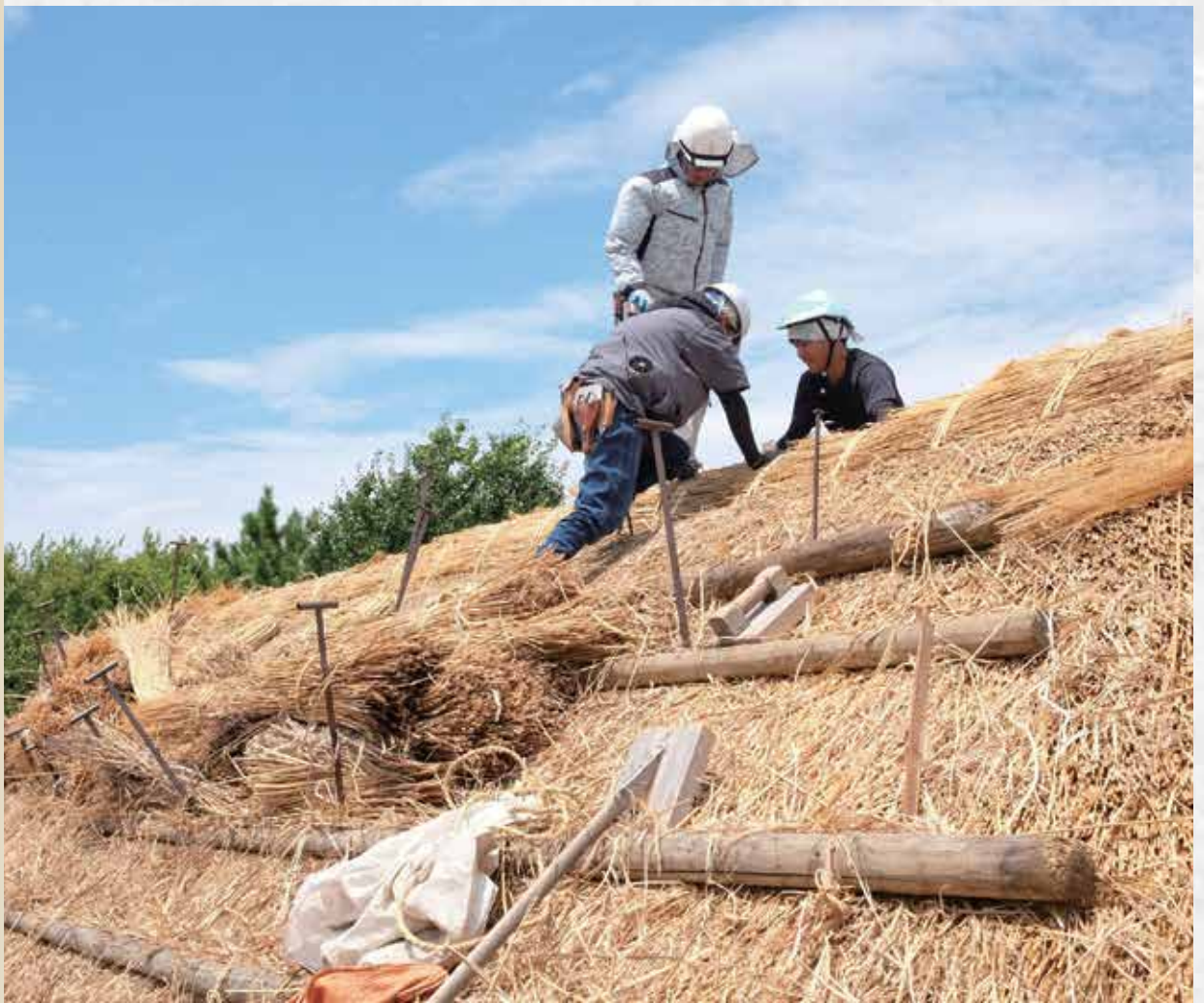
写真／8月下旬、屋根の茅が葺き上がり、棟を固定する。
