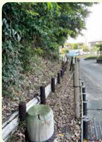
久田緑地林縁部の草刈後の様子。土留めのそだ柵には林内の竹材を使用
