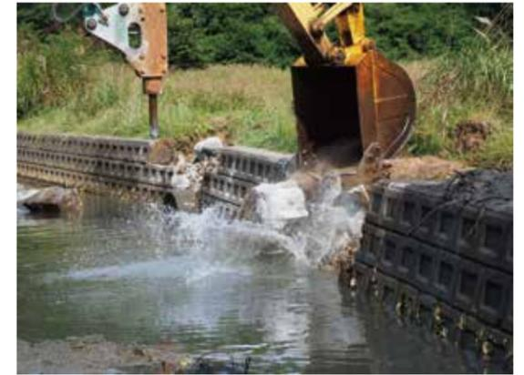
東日本大震災に起きた地殻変動による地盤沈下によって、生まれた塩性湿地を災害復旧工事の一環で護岸を開削し、横を流れる西舞根川とつなげ、淡水と海水が交わる汽水域の環境に。
