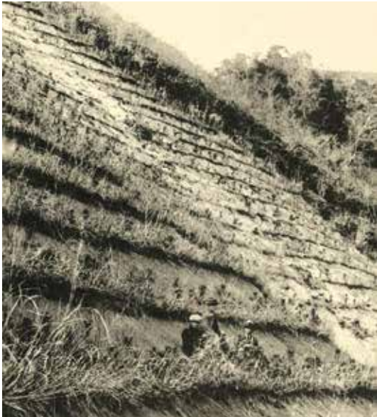
写真4 三保村箒沢の山腹工事(菅筋工・編柵工・マツ植栽)大正14年度工事 写真5 山北町世附に残る現採石の堰堤 昭和2年度工事
