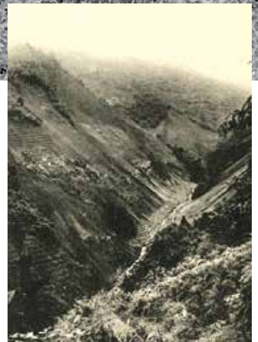
共和村人遠の溪岸崩壊と山腹工事 (大正13年頃)
